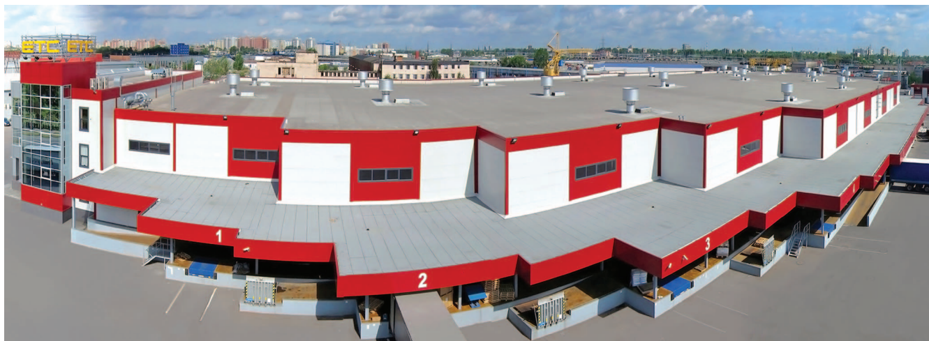
логистический центр ГК «ЕТС», Санкт-Петербург
